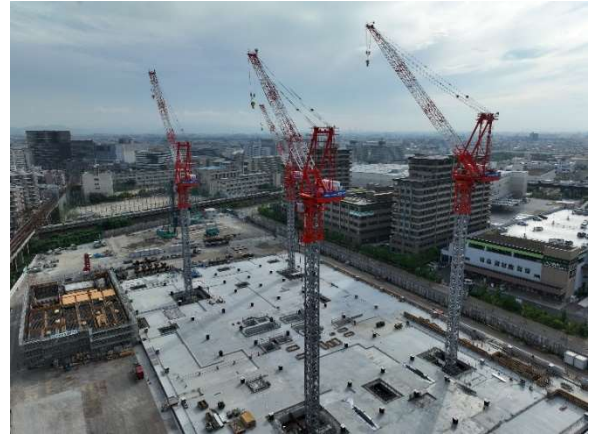
合同パトロール時の現場の状況
